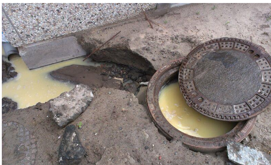
Foto: verzakking ter plaatse van riolering
