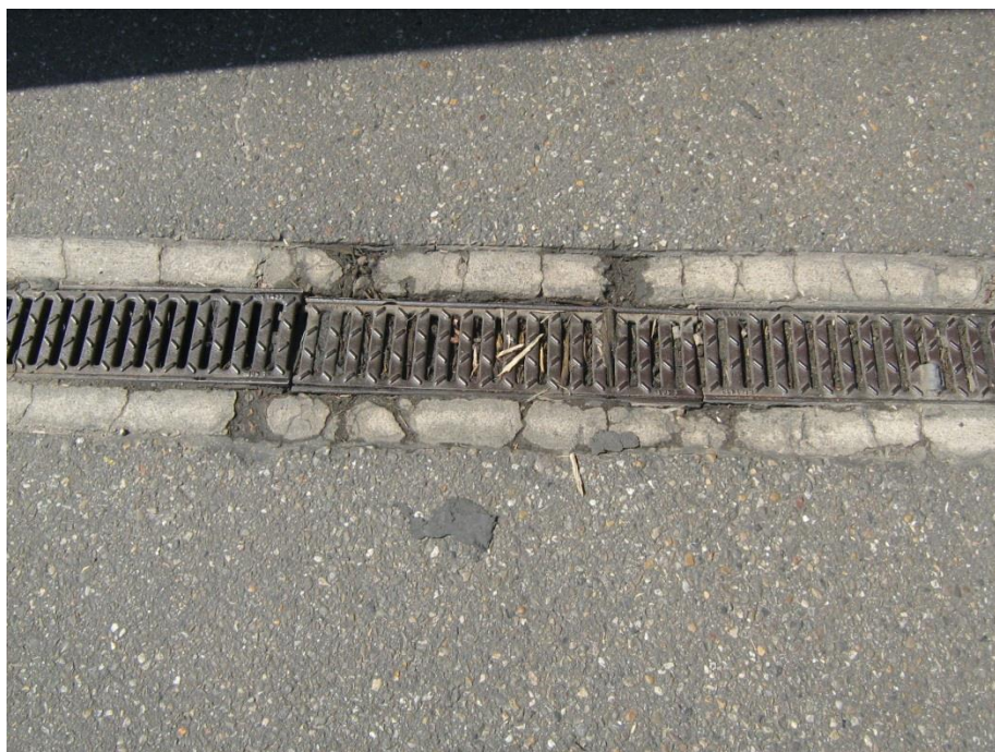
Foto: aansluiting op lijngoot.
