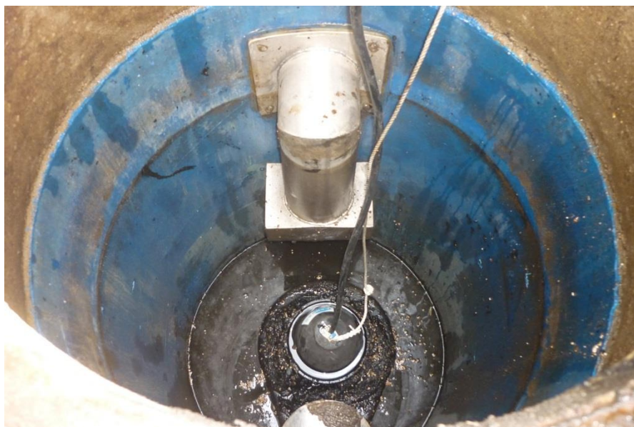
Foto: afsluiter in afscheiderinstallatie.
