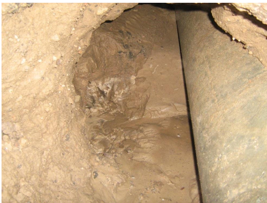
Foto: lekkage leidingwerk.
